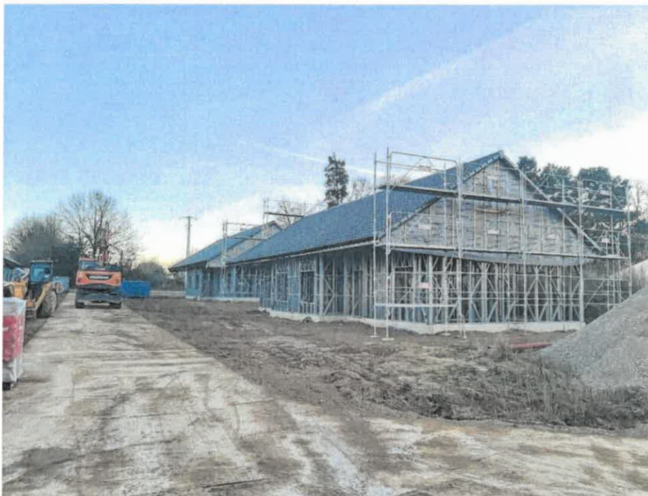
Les logements sociaux en acier sont déjà montés rue de Molliens-Vidame.
